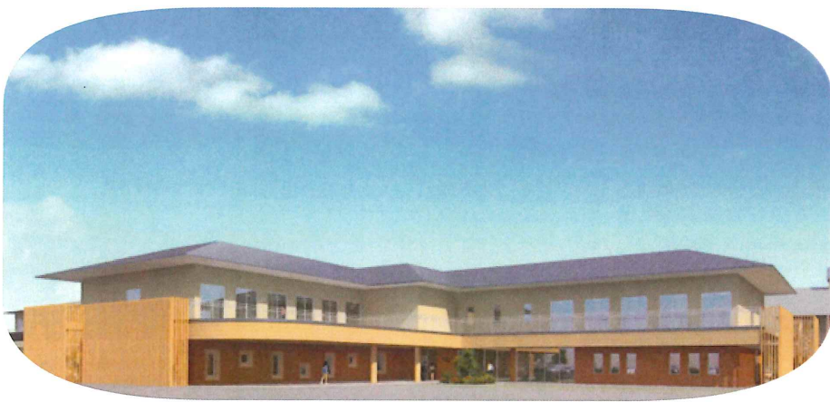
大規模改修で建設予定の新棟
